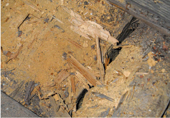
Beispiel eines befallenen Holzes
