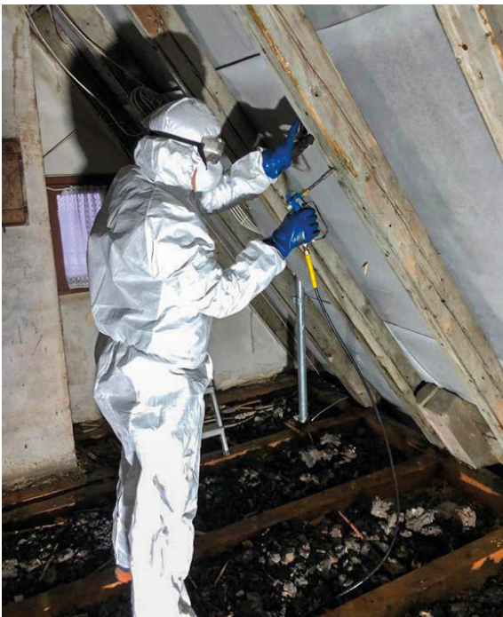
Arbeiten im Injektionsverfahren
