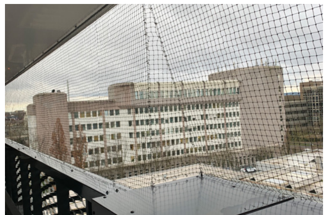
Wichtig: Zu kleine Maschen (wie bei Fliegengittern) verdunkeln den Raum dahinter stark und sind windanfällig.
