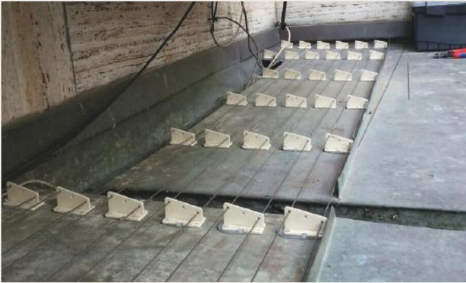
Taubenabwehrsystem mit Keramikisolatoren
